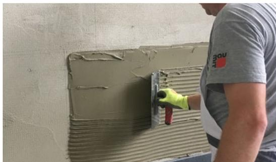
Lepljenje u dvostrukom sloju na podlogu i oblogu pomoću Baunit CeramicFix/FlexTop
