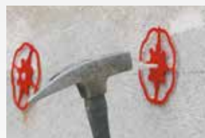
Baumit lepljive pričvršnice umeću se u bušotinu te se zabijaju plastični klinovi
