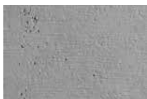
Tehnika grubog betona
