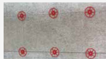
Baumit lepljive pričvršnice međusobno su udaljene 40 x 40 cm.
